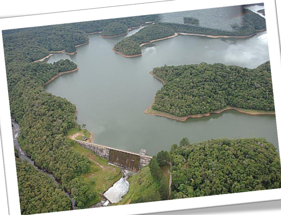
Barragem Ribeirão do Campo
