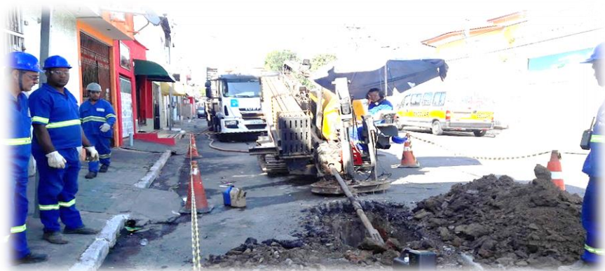
Sistema Pipe Bursting
