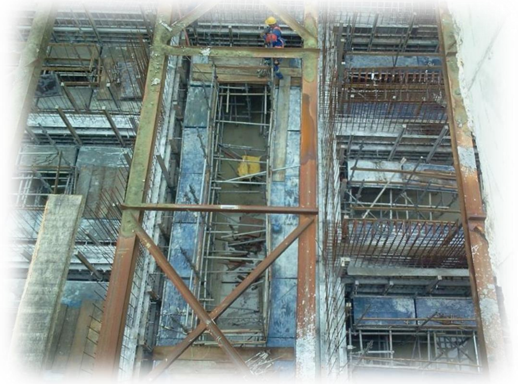
EEE Final – ITi-16 (ETE Suzano) Vista Geral – Obras
